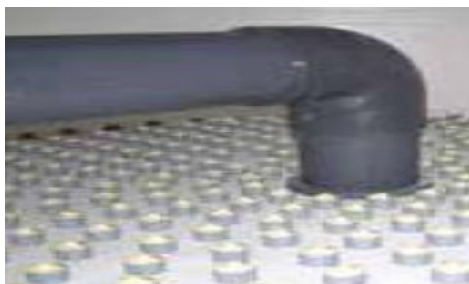
Piastra di base per supporto sabbie filtranti
