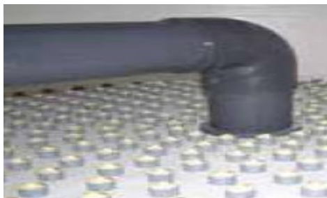
Piastra di base per supporto sabbie filtranti
